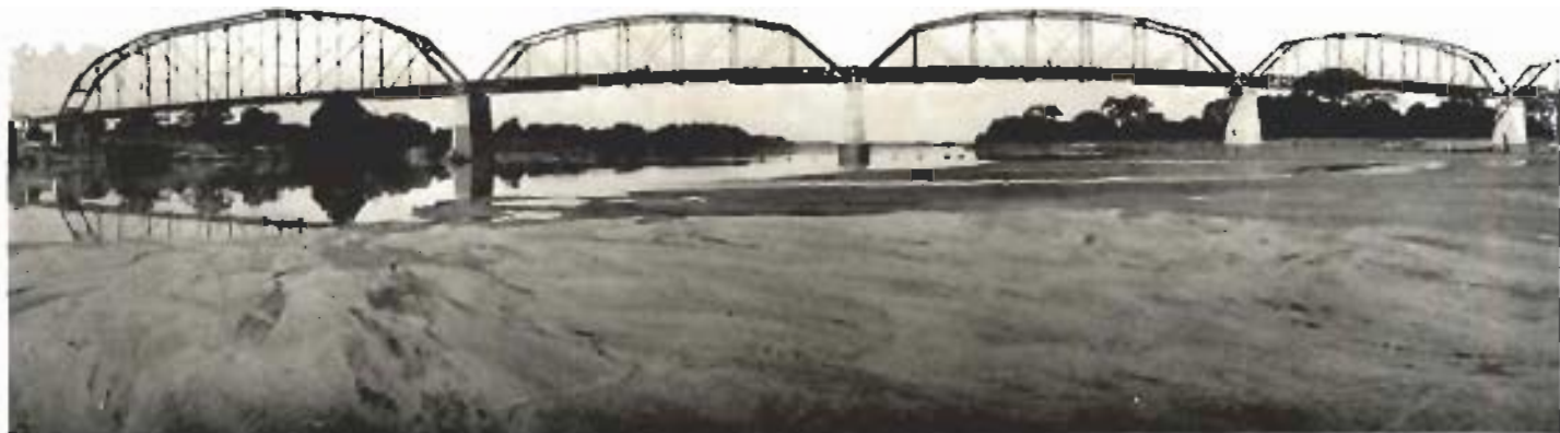
No. 63.—Steel bridge over the River Lempa. (International Railway of Central America). Puente de acero sobre el río Lempa. (Terro-carriles Internacionales de Centro America)
