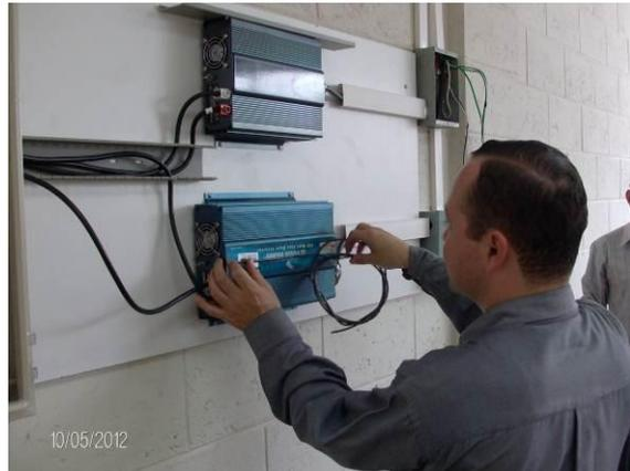
Fig. 19. Instalación de inversores
