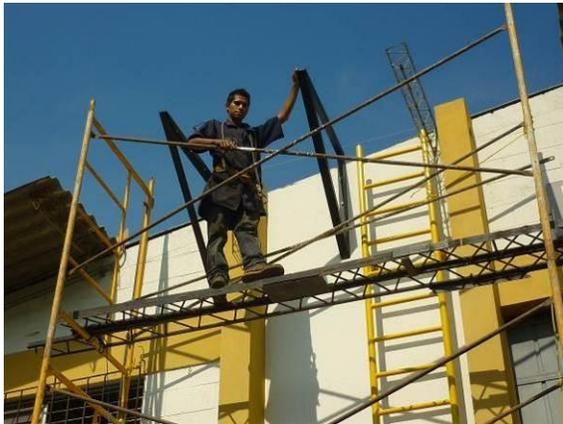
Fig. 12. Instalación de soportes en canasta de trabajo
