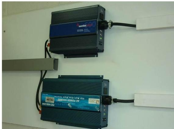
Fig. 23. Inversores instalados
