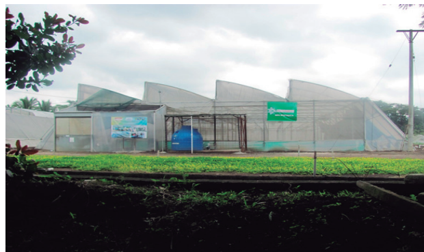
Fig. 1 Invernadero “Diente de Sierra” con sistema de riego automatizado implementado.
