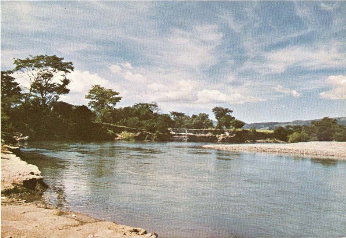
Sitio identificado para la construcción de la Presa para la captación del Río Lempa.
