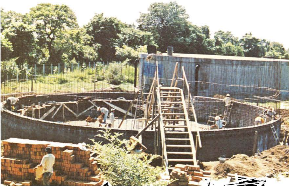
Construcción de tanque de almacenamiento de 1,000 M 3 de capacidad, en la zona alta de la ciudad de Usulután, Departamento de Usulután.
