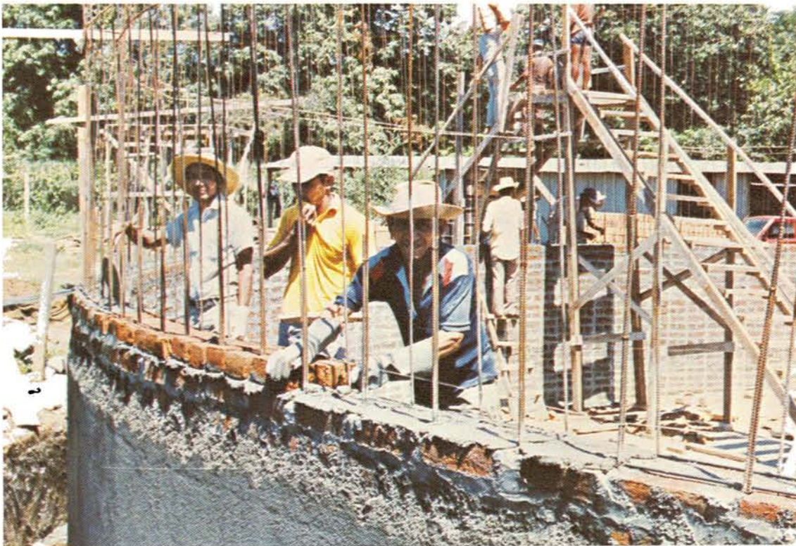
Construcción de tanque de almacenamiento de 1,000 M 3 de capacidad, en la zona alta de la ciudad de Usulután, Departamento de Usulután.
