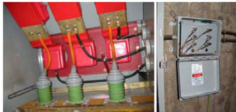
**Figura 2-56. Fijación de captadores según la máquina, cableado e instalación de la caja de terminales**
