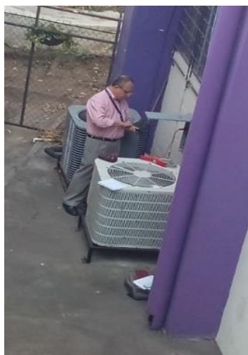
Medición de aires acondicionados utilizando el analizador C-80, CIRCUTOR
