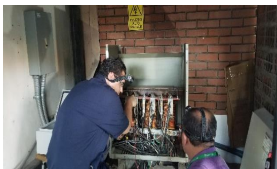
Instalación del medidor ACCUENERGY
