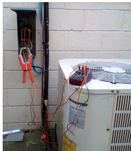
Medición de aires acondicionados utilizando el analizador C-80, CIRCUTOR
