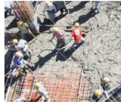
Concreto tipo acera.
