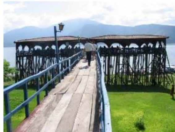
Imagen 22: Vista anterior del muelle del Hotel Torremolinos.
