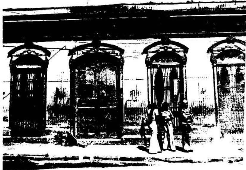
Lámina y madera se integran en el diseño equilibrado y simétrico de esta fachada, en una calle de San Salvador.
