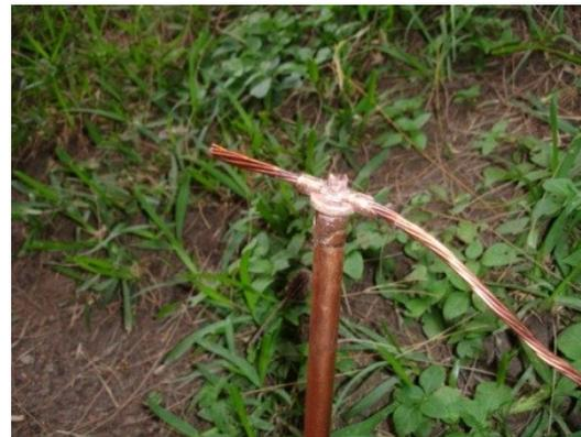
Fotografía 1. Unión por soldadura exotérmica.
