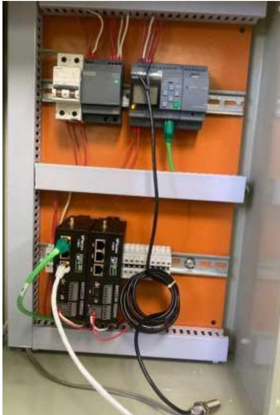
FIGURA 96: MODULO DE MONITOREO DE VARIABLES ANALOGICAS Y DIGITALES.
