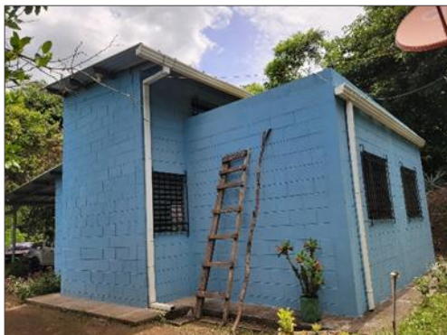
Vivienda de bloque de concreto.
