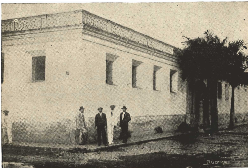
HOSPITAL DE AHUACHAPAN
