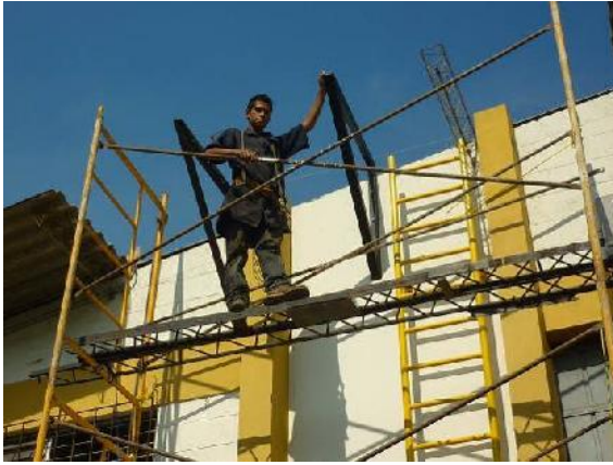
Fig. 12. Instalación de soportes en canasta de trabajo
