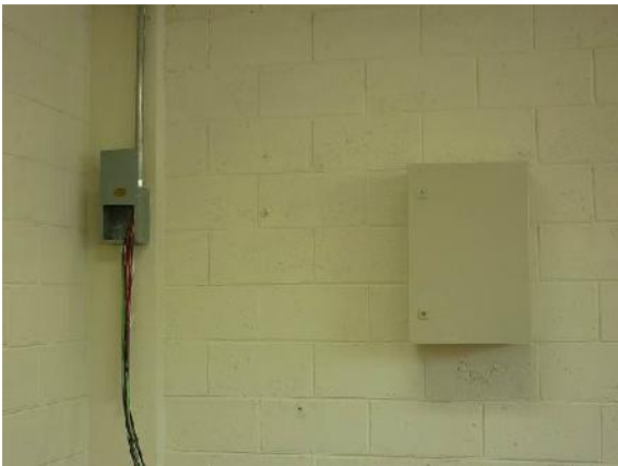
Fig. 18. Panel de control en proceso de instalación
