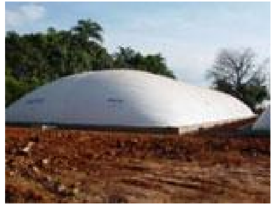
Figura # 4, Biodigestor de estructura flexible, bioreactorcrc.wordpress.com
