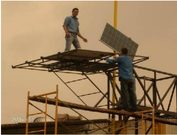
Fig. 16. Estudiantes instalando los paneles fotovoltaicos
