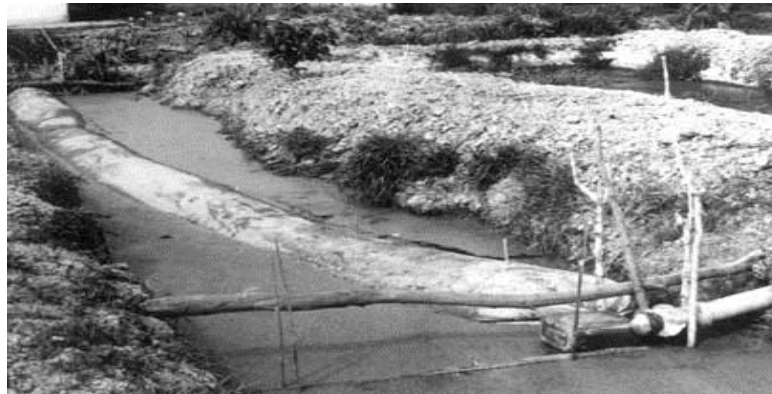
Figura # 6, Biodigestor de estructura flexible.
