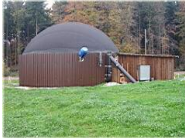
Figura # 7, Digestor con tanque de almacenamiento tradicional y cúpula de polietileno, www.cubasolar.cu
