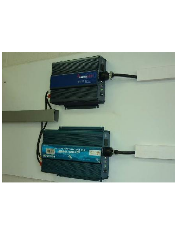
Fig. 23. Inversores instalados
