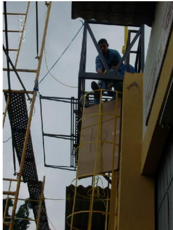
Fig. 15. Estudiantes subiendo los paneles Fotovoltaicos
