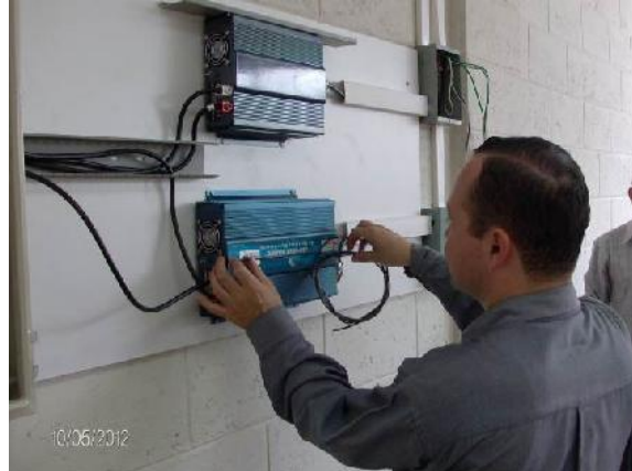
Fig. 19. Instalación de inversores
