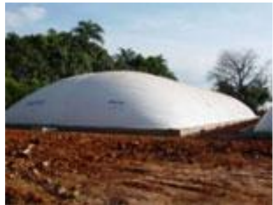
Figura # 4, Biodigestor de estructura flexible, bioreactorcrc.wordpress.com
