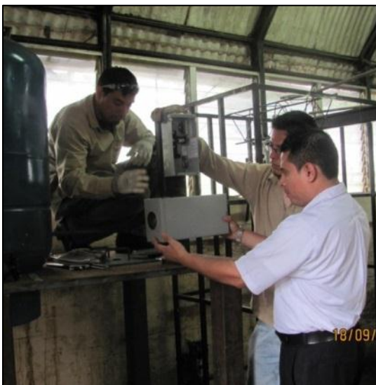
Construcción del biodigestor prototipo.
