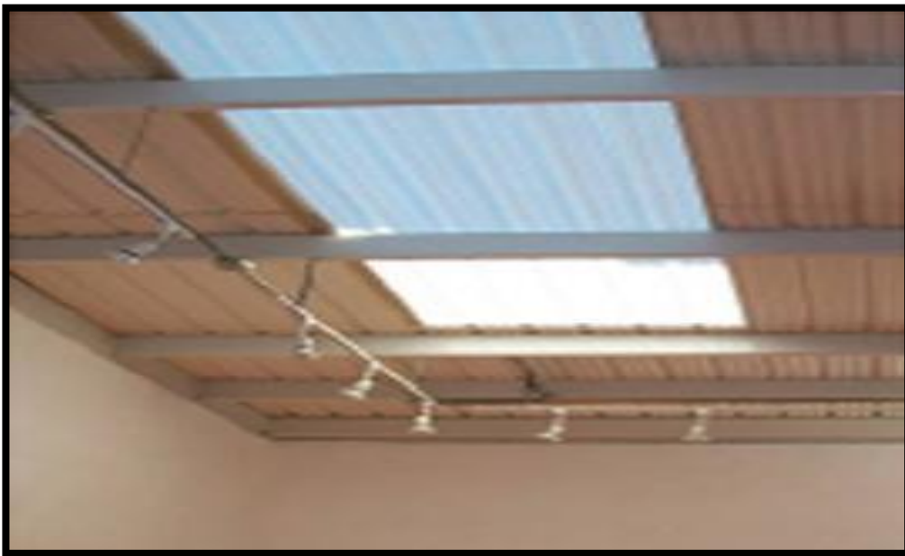
Figura. 30 Cubierta con lámina traslucida.
