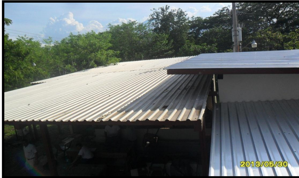
Figura 54. Laboratorio de civil con Lámina de Zinc Alum.
