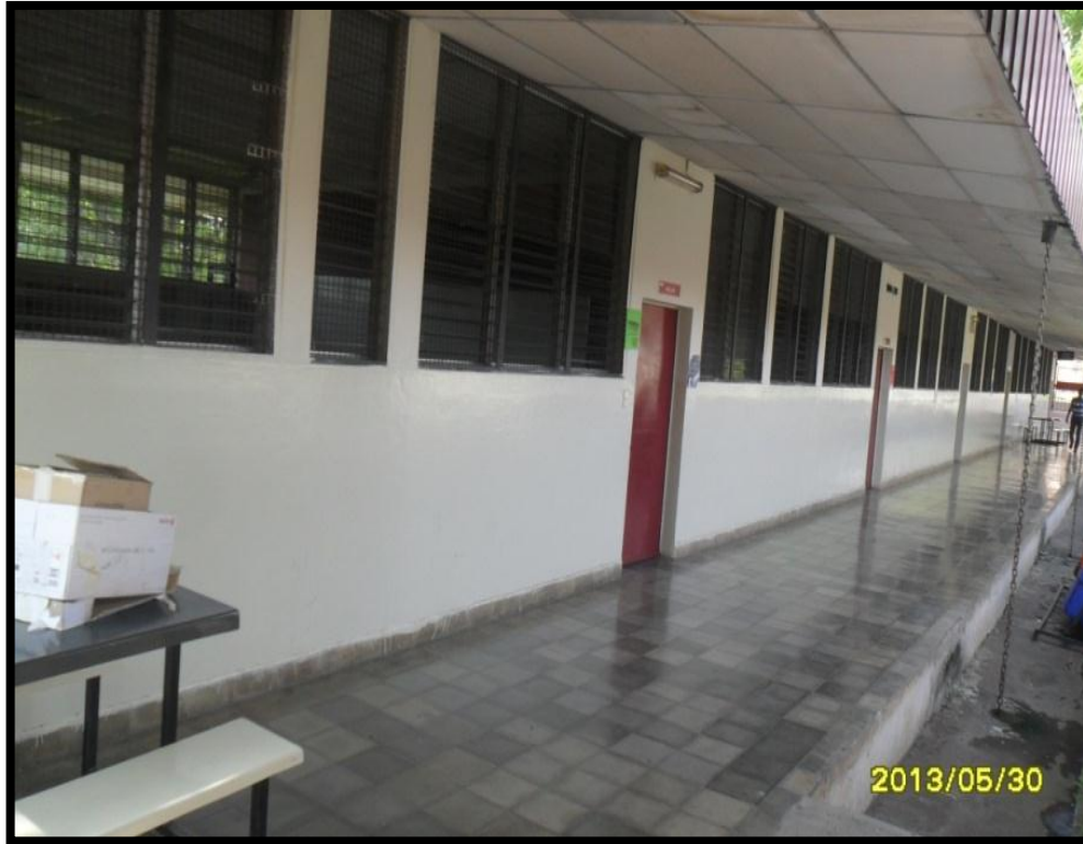
Figura. 50 Pabellón de aulas desde 1 a la 6 está construido con ladrillo de obra.
