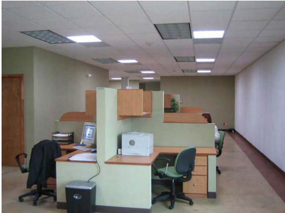
Figura 83. Oficina con dos sistemas de iluminación.
