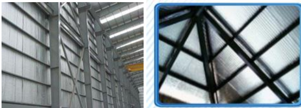
Figura. 39 Aplicación del aislante térmico reflectivo en techos y paredes.
