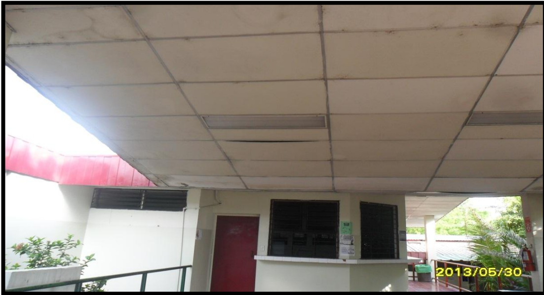
Figura 56. Cielo falso en pasillo frente a oficinas administrativas.
