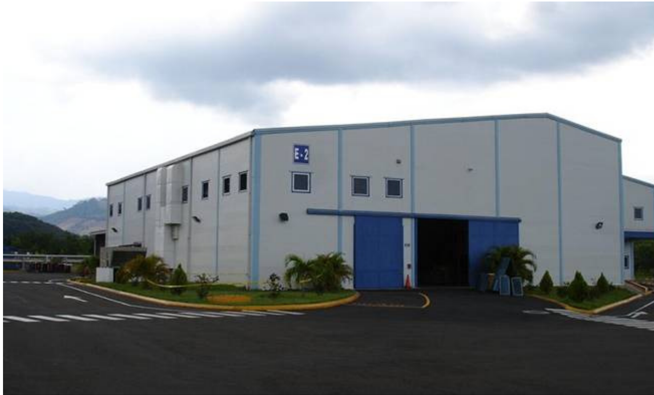
Fig. 11.2 Panorámica de la Casa de Máquinas de la Central Termoeléctrica Talnique.
