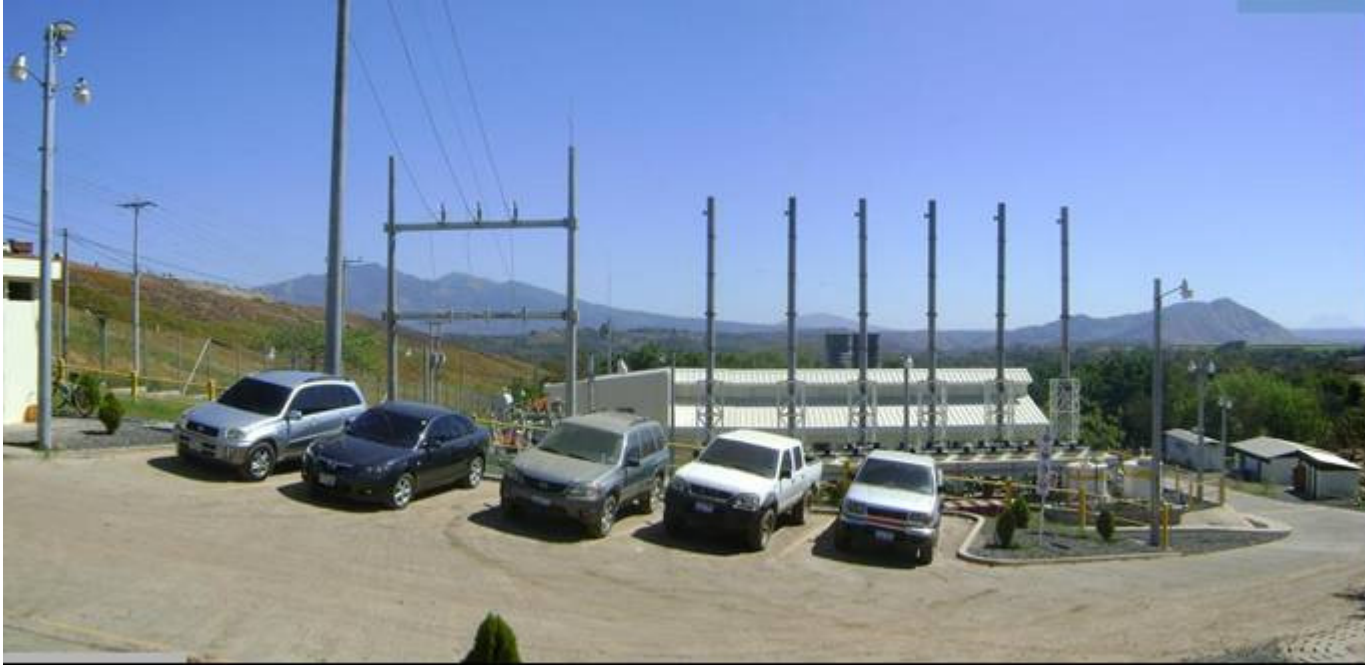
Fig. 11.4 Panorámica de la Casa de Máquinas de la Planta AES-NEJAPA.
