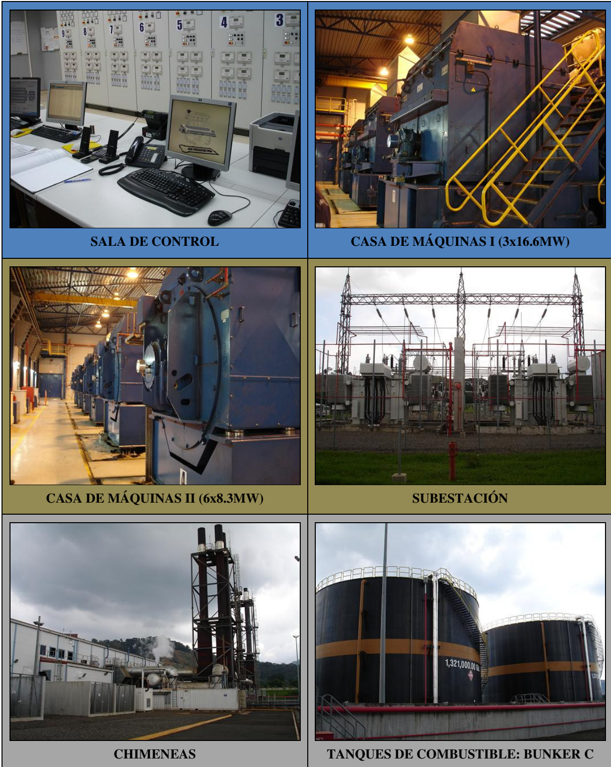
Fig. 11.1 Principales componentes de la Central Termoeléctrica Talnique.
