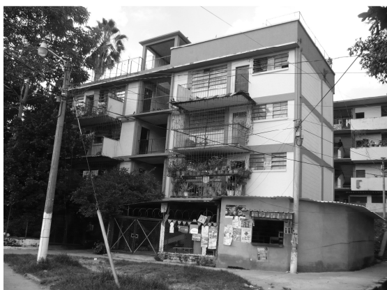
Foto 19. Fachada principal de uno de los edificios del centro urbano.
