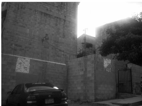
Foto 31. Detalle de las paredes del condominio habitacional.
