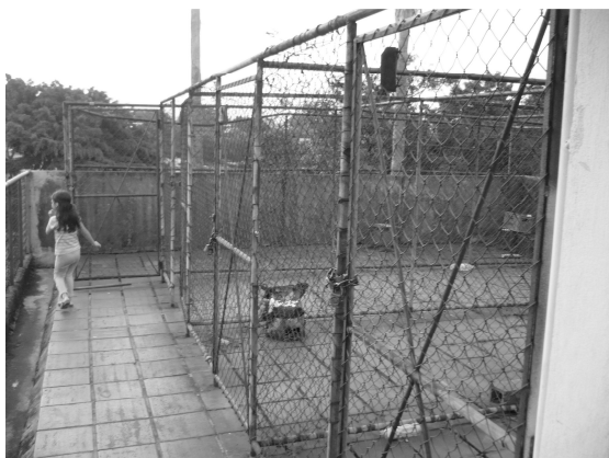
Foto 27. Vista del área de tendedero sobre la azotea. (Fuente: fotografía tomada por la autora.)
