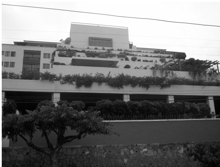
Foto 4. Condominio Las Terrazas. Vista de la fachada principal del edificio.
