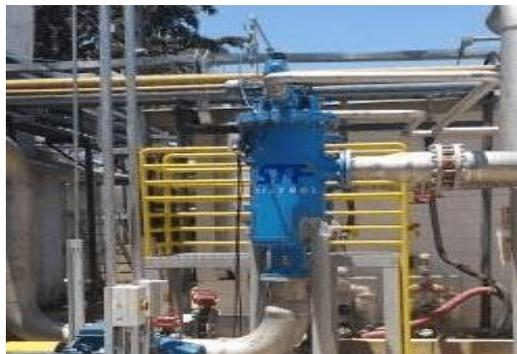
**Figura 28. FILTRO DE MALLA AUTOLIMPIANTE FMA 11,000**
