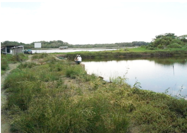
Cooperativa La Carranza, Estanque 3. Evaluación del estado de la infraestructura.
