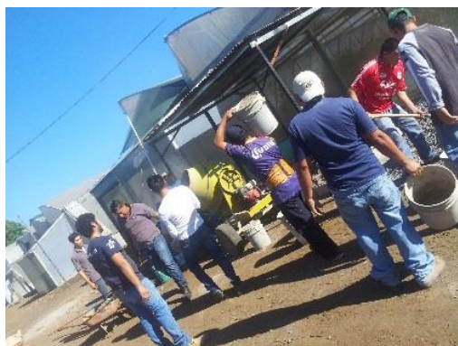
8) Colocación de agregados (Arena y Cemento para elaboración de loza de concreto )
