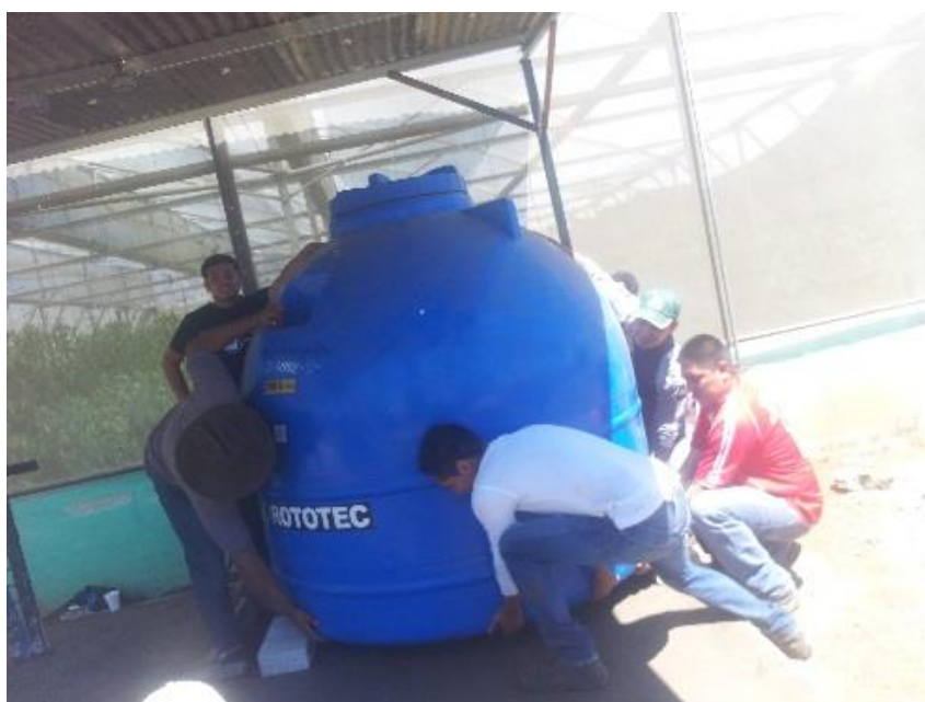
10) Colocación de tanque de 3000lts
