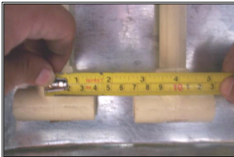
Medición de las “T” dentro de la caja para su instalación.
