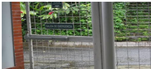
SALIDA DE EMERGENCIAS
