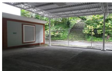
SALIDA DE EMERGENCIAS
