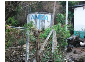
Ilustración 115 TANQUE DE AGUA
