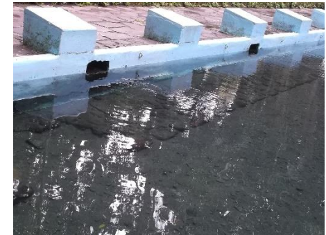
CONDUCTOS DE AGUA
