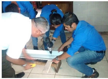
Estudiantes y docentes durante la instalación de sistemas eléctricos
