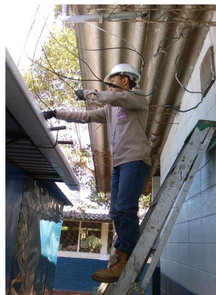
Estudiantes realizando inspección de circuitos eléctricos.
