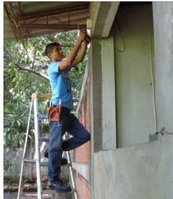
Estudiante realizando instalación eléctrica.
