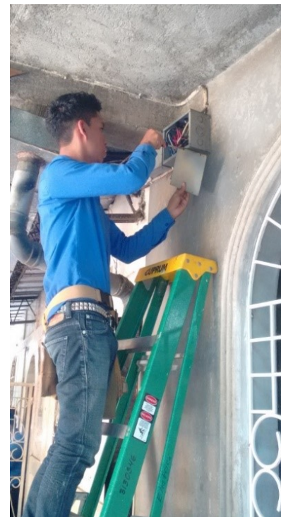
Estudiante realizando instalación de caja de registro
