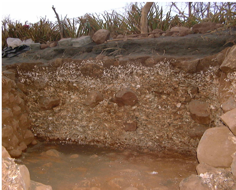
Foto. 3 Muros de piedra con el relleno de conchas de moluscos.
