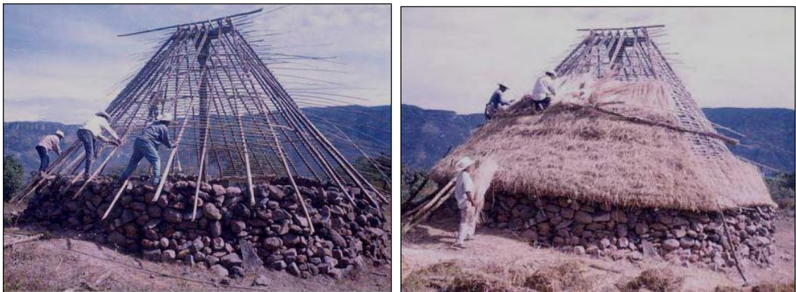
Figuras 31 y 32. Reconstrucción de un tuki (tukipa) y colocación de su techo, en Guadalupe Ocotán, Nayarit, México. (Fuente: Téllez, 2006).
