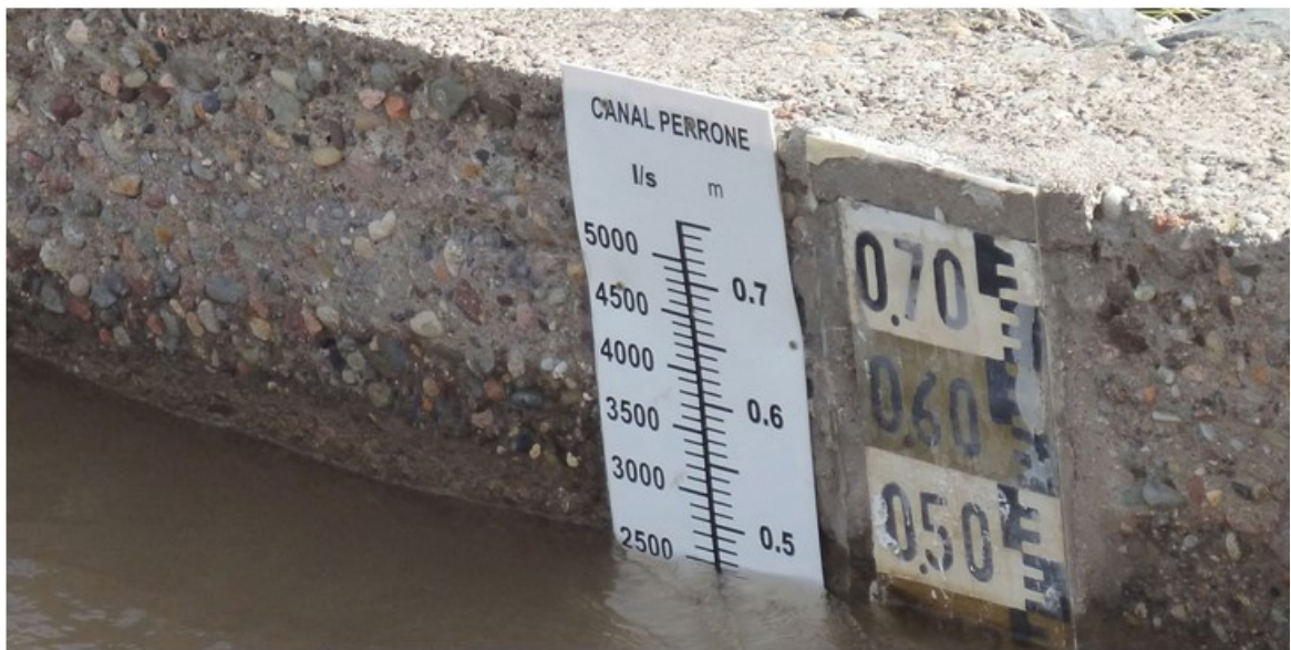
Foto 1: Sensor por inmersión, utilizando regla telemétrica.
