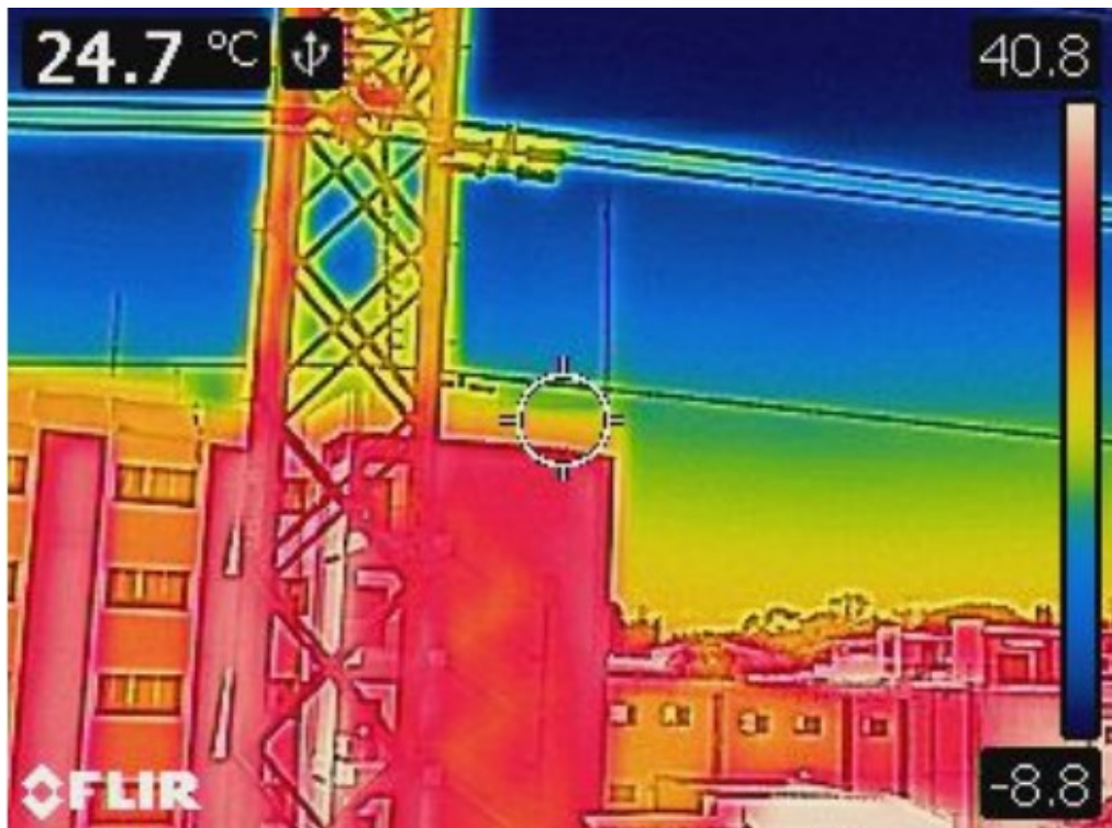
Fig. 45. Termogramas de locación 6
