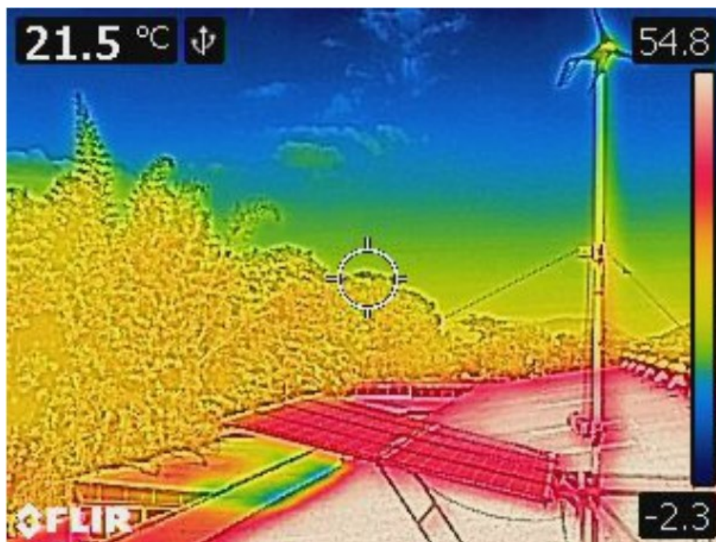
Fig. 40. Termogramas de locación 2
