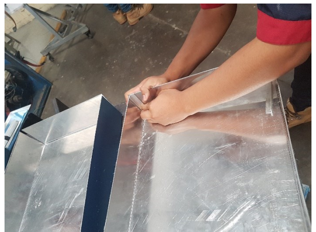
Proceso de medición, trazo y corte de material de aluminio para estuche
