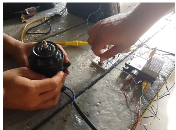
Prueba de circuito variador de velocidad.
