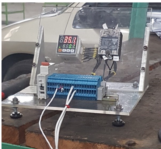
Medición de temperatura de trabajo de resistencias eléctricas.
