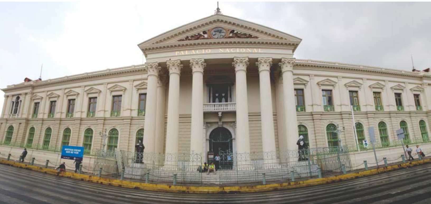
Fotografía 26. Fachada este del Palacio Nacional, El Salvador. Fotografía por Gustavo Martínez (2017).
