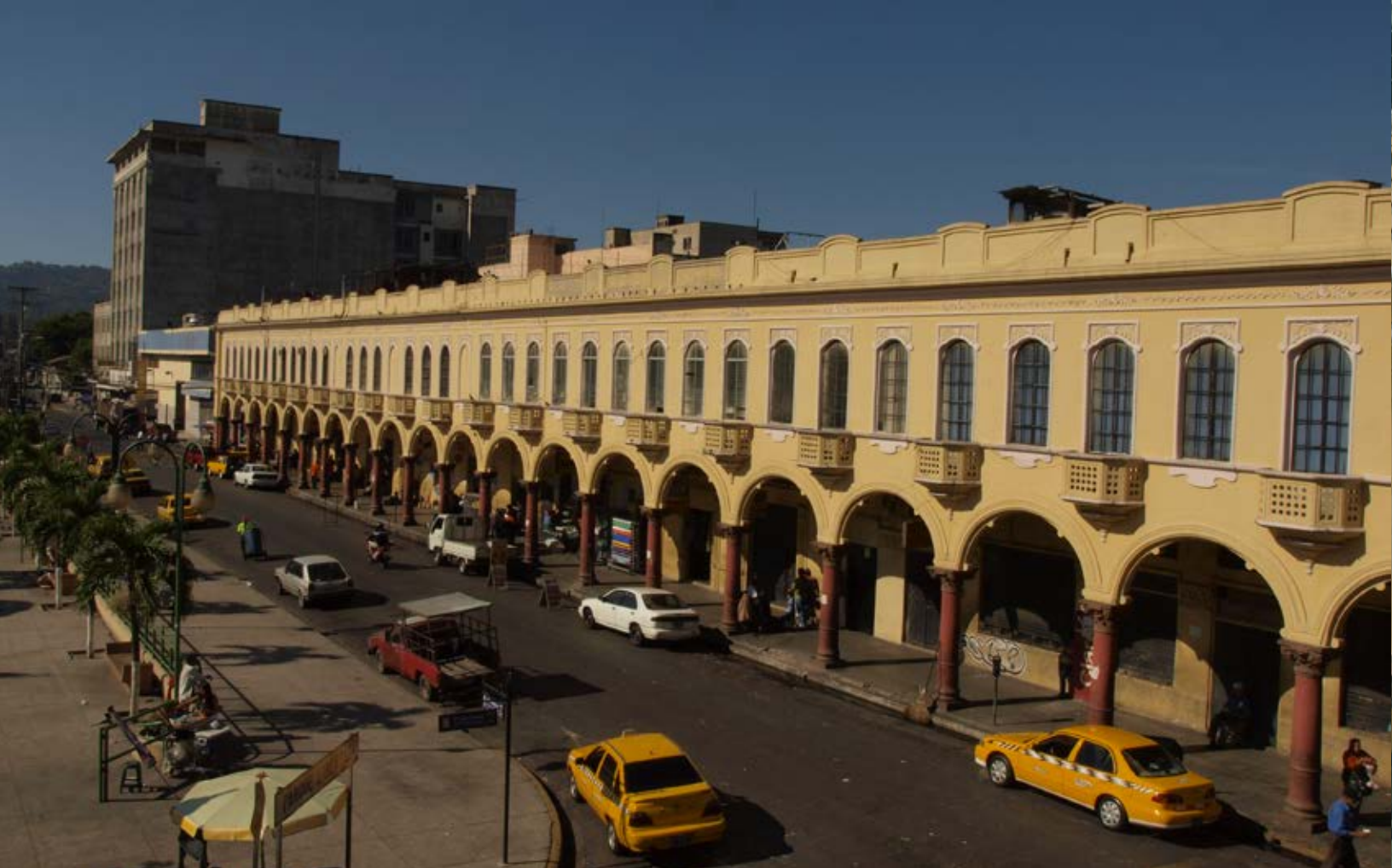
Fotografía 22: Fotografía del Portal de Occidente en el Centro Histórico de San Salvador. Fotografía por Nelson Crisóstomo. (N. Crisostomo, 2015) 2 .
