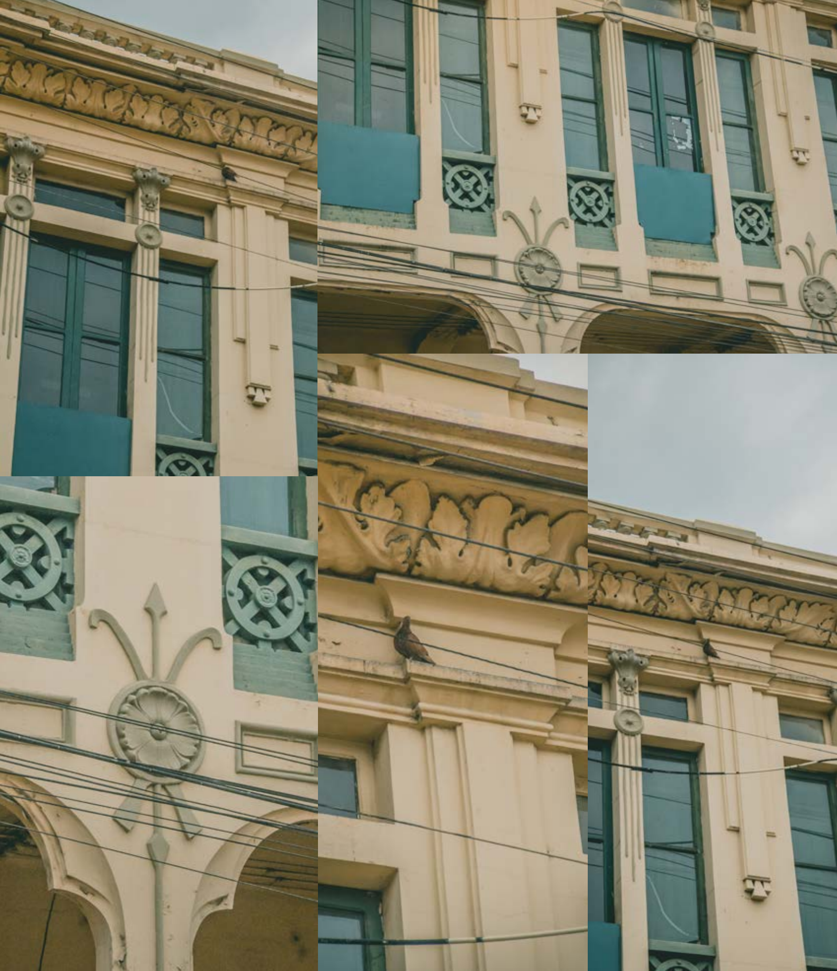
Fotografía 21. Rasgos arquitectónicos de la fachada del Portal La Dalia. Fotografías por Gustavo Martínez (2017)
