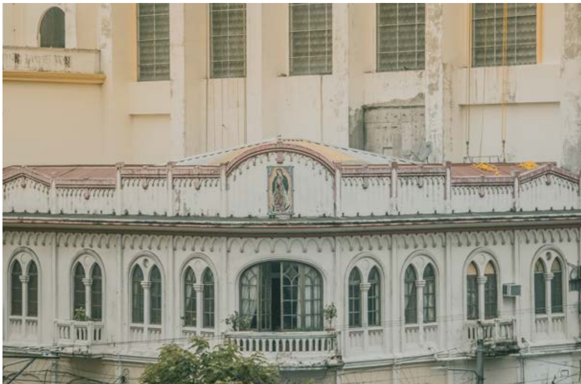
Fotografía 9. Fotografía de la segunda planta del edificio Bank Of London and Sud America LTD. y la Nunciatura Apostólica, presente en el Inventario de Bienes Culturales Inmuebles. Fotografía por Gustavo Martínez (2017).
