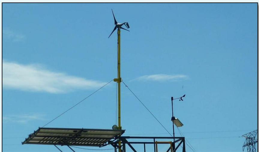
Sistema híbrido de paneles solares, aerogenerador y estación meteorológica instalados para prueba piloto en Sede Central.
