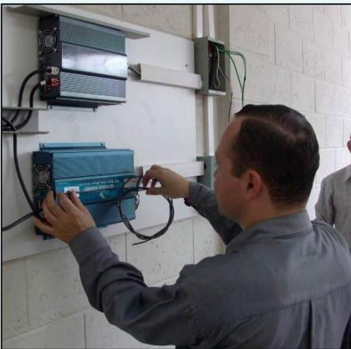
Instalación de inversores en el laboratorio experimental de energías renovables.
