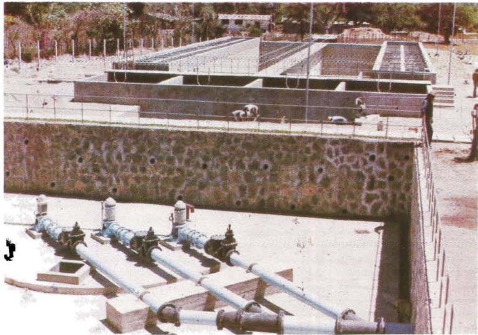
PROYECTO RIO CUAYA. OBRA TERMINADA.
