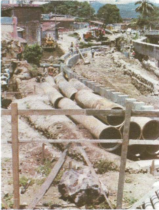
REUBICACION DE CAÑERIA DEL PUENTE DE LA VEGA.
