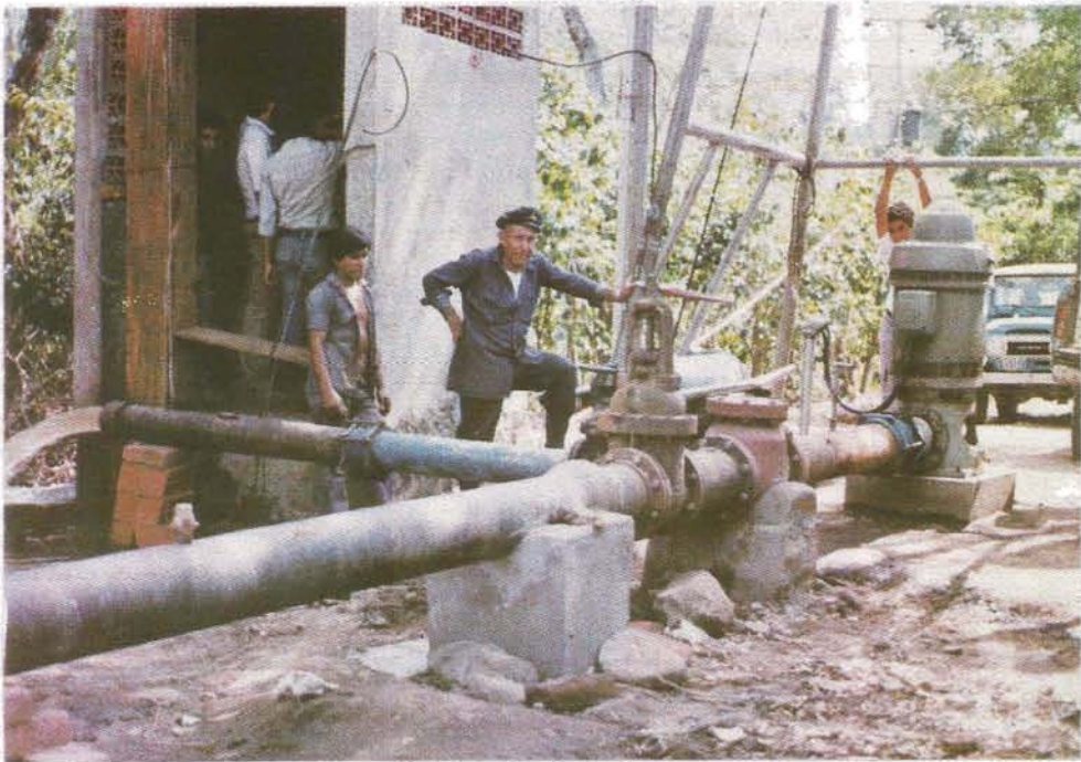
NOTESE LA CLARIDAD DEL AGUA BOMBEADA MOMENTOS DESPUES DEL INICIO DE LA PRUEBA.
