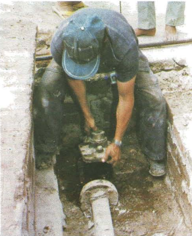
LEVANTAMIENTO DE UN MEDIDOR DE ALTO CONSUMO PARA PROCEDER A SU CAMBIO.
