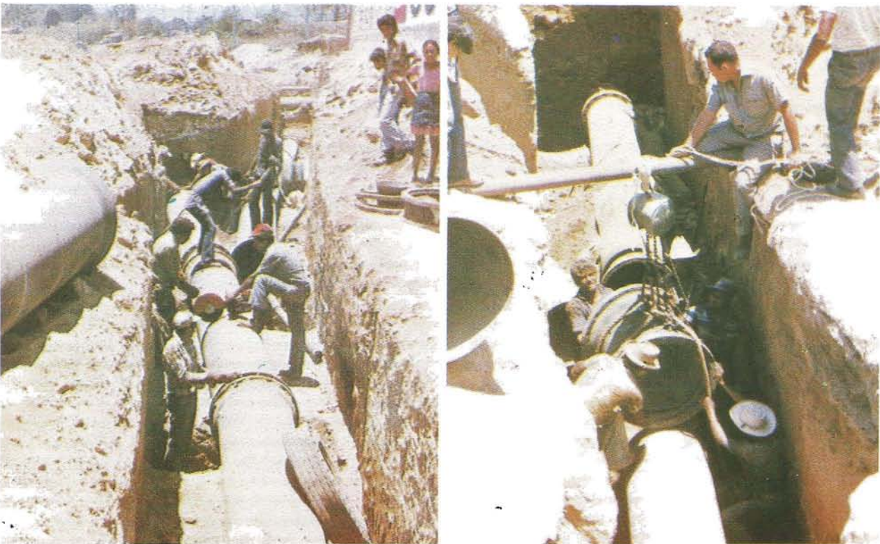
REUBICACION, PROFUNDIZACION Y ENTRONQUE DE CÁÑERIA DE 24" EN EL PROYECTO DE INTERSECCION DE CARRETERAS CA-1 Y CA-12 (BY PASS)
