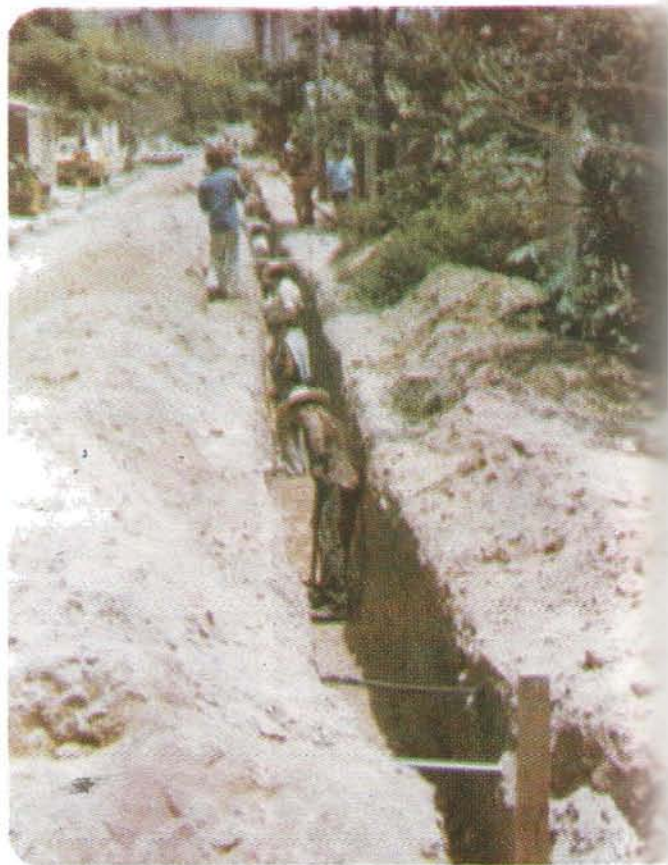
EXCAVACION PARA INTRODUCCION DE ACUEDUCTOS. COL. SAN MARCOS N° 3, SAN SALVADOR.
