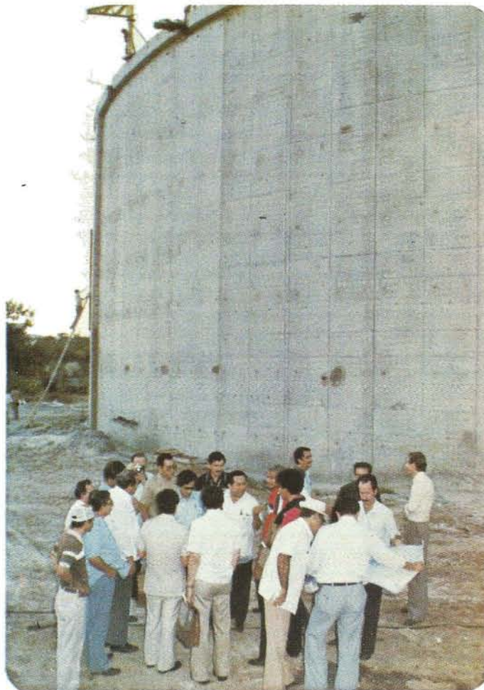
VISITA DE LOS DELEGADOS DE LOS PAISES PARTICIPANTES, A UNA DE LAS OBRAS DEL PROYECTO ZONA NORTE, I ETAPA.
