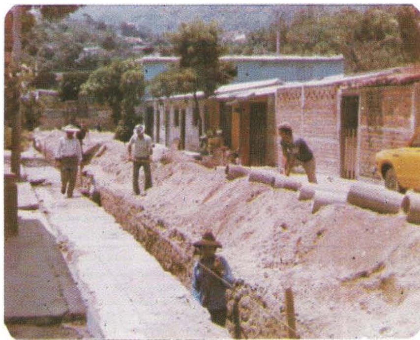
TRABAJOS DE ALCANTARILLADO SANITARIO. COL. SAN MARCOS N° 3, SAN SALVADOR.
