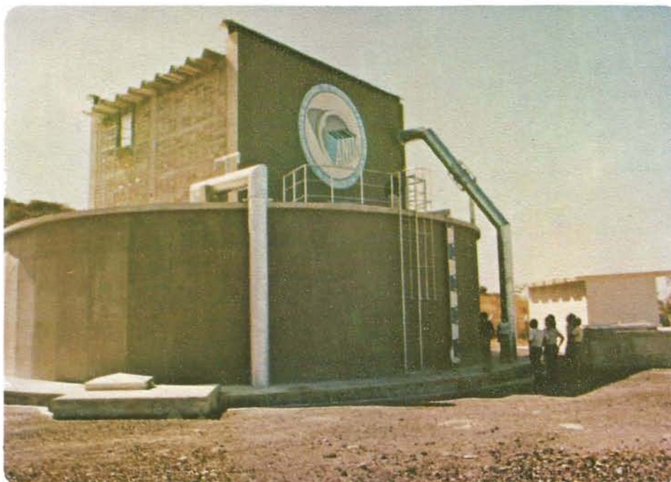
Tanque de Aereación—Opico.
