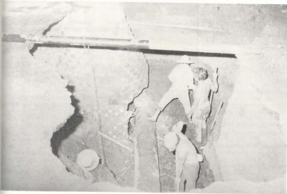
*Cuadrilla de emergencia trabaja en horas nocturnas para reparar tuberías instaladas cerca del Centro de Gobierno.*
