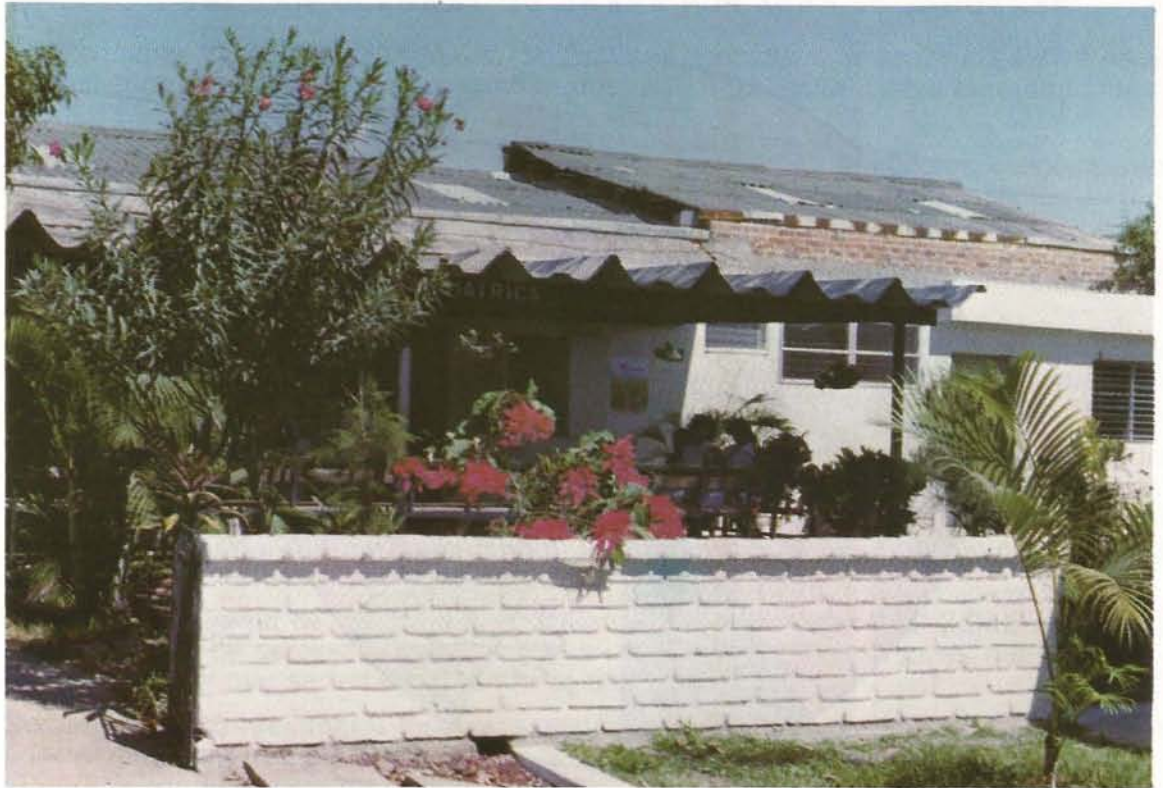
Local en que funciona la Clínica Pediátrica, que da atención médica y medicinas gratuitas a los hijos de los trabajadores de ANDA, menores de 10 años.
