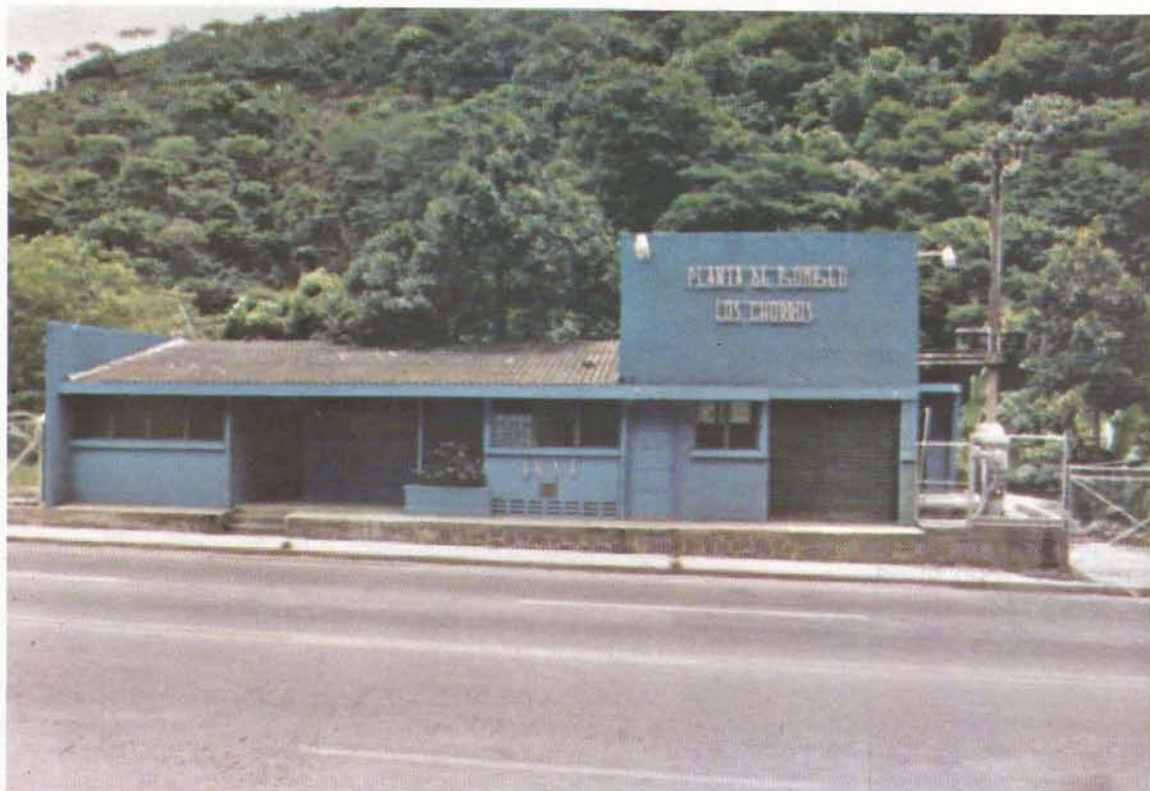
Planta de Bombeo Los Chorros, frente al turicentro del mismo nombre, es una de las fuentes de abastecimiento de agua potable para el AMSS.
