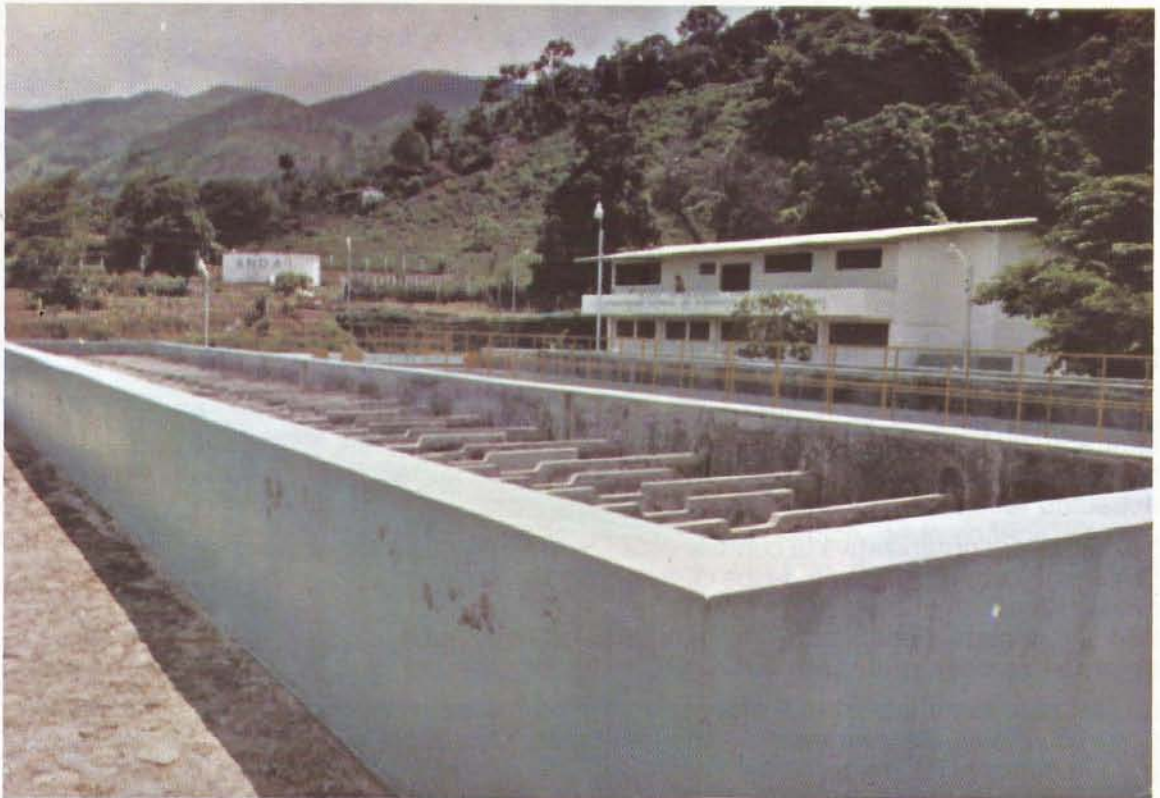
Aspecto de la planta de tratamiento de Agua Potable "Tamulasco" en Chalatenango, Depto. de Chalatenango.
