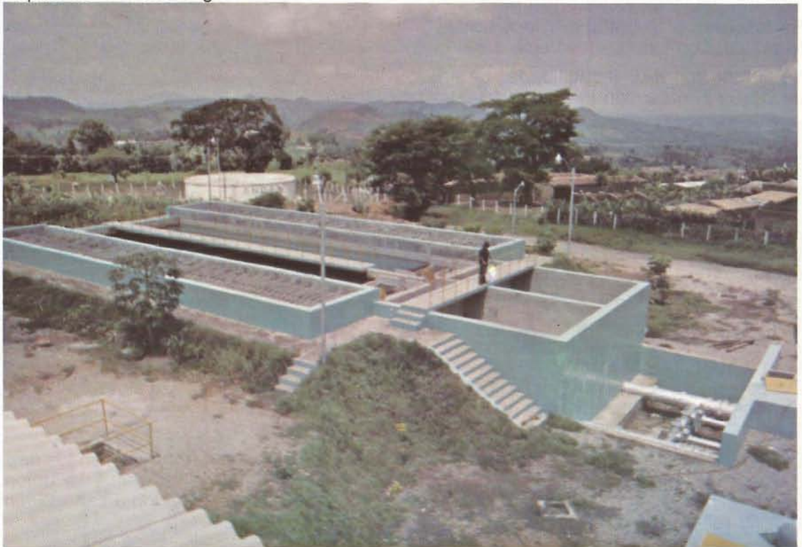
Vista panorámica de la planta de tratamiento de Agua potable "Tamulasco", construida a un costo aproximado de 1.8 millones de colones e inaugurada el 27 de Julio de 1987.
