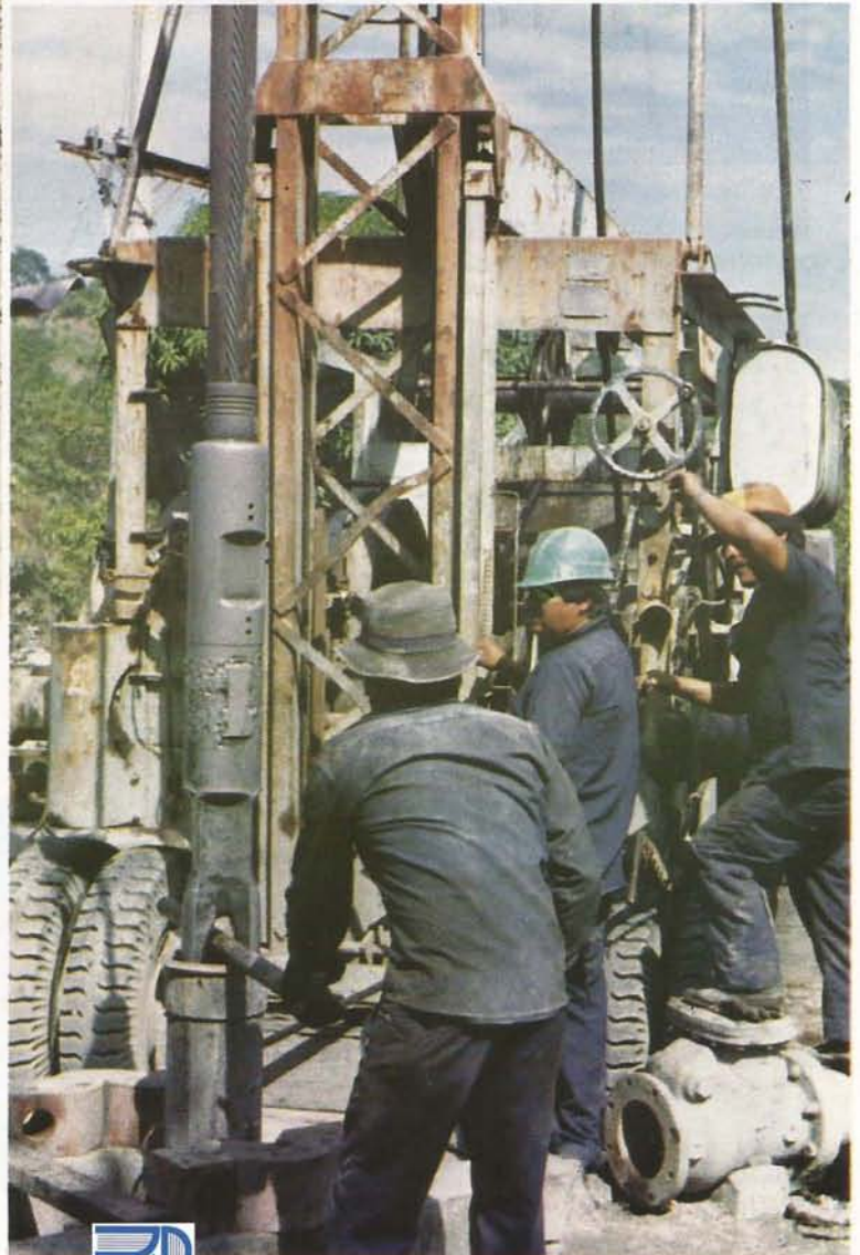
Rehabilitación de Pozo Joya Grande - 1, ubicado en las cercanías del Lago de Ilopango.
