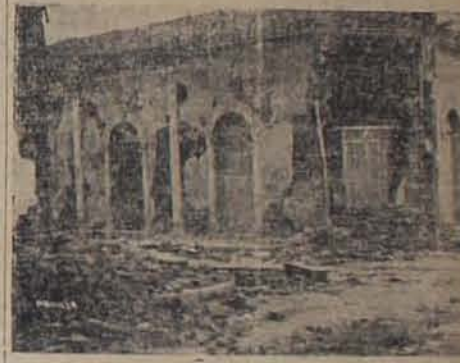
El edificio de la Gobernación totalmente en ruinas. Departamental de La Paz, casi
