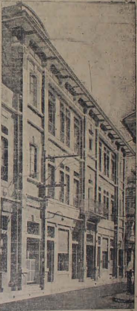
Palacio de cemento armado monolítico asimétrico e incombustible, propiedad de la señora doña Leonor de Quiñones. Este edificio de tres pisos, es parte del Hotel Nuevo Mundo. La armonía de sus líneas arquitectónicas modernas, constituye un éxito artístico y uno de los mejores adornos de la Capital. Es obra original del Arquitecto don Alberto Ferracuti.
