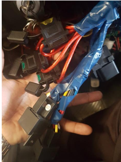
Figura 2.1 Restauración del ramal eléctrico de control
