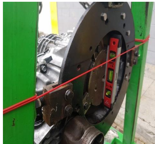
Instalación y nivelación de discos sostenedores.
