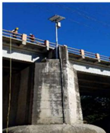
Sistema SAT instalado en el Puente Urbina de San Miguel.
