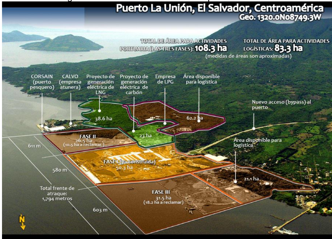
Figura 9. Fases de construcción del puerto de La Unión
