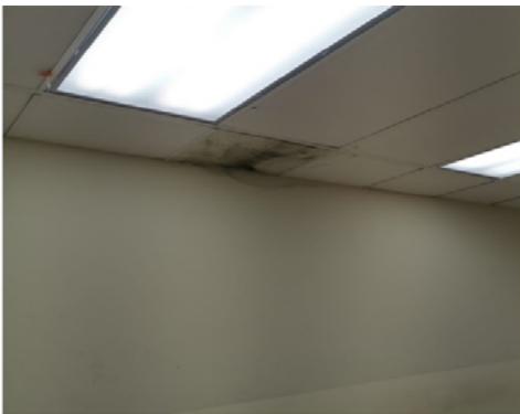
■ Reparación filtración de agua y cambio de losetas en el cabañas "D".
