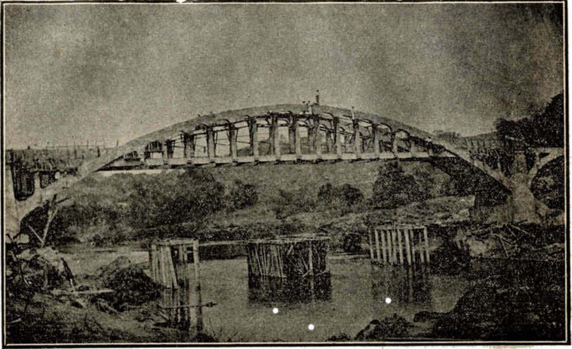
PUENTE «SAN MARTIN».—Arco central de 60 metros.
