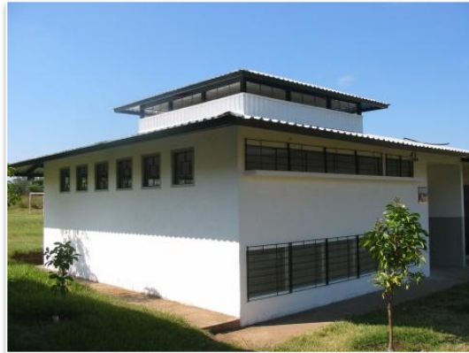
Fotografía 2: Aula C101 después de la remodelación
