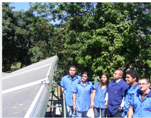
Fotografía No 1: Estudiantes e instructor visitan las instalaciones de colectores fototérmicos en la Sede Central de ITCA – FEPADE
