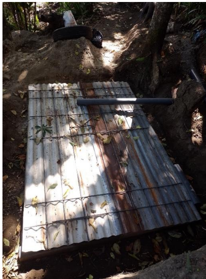
Imagen 67. Colocación de losa en el pozo para protegerlo.
