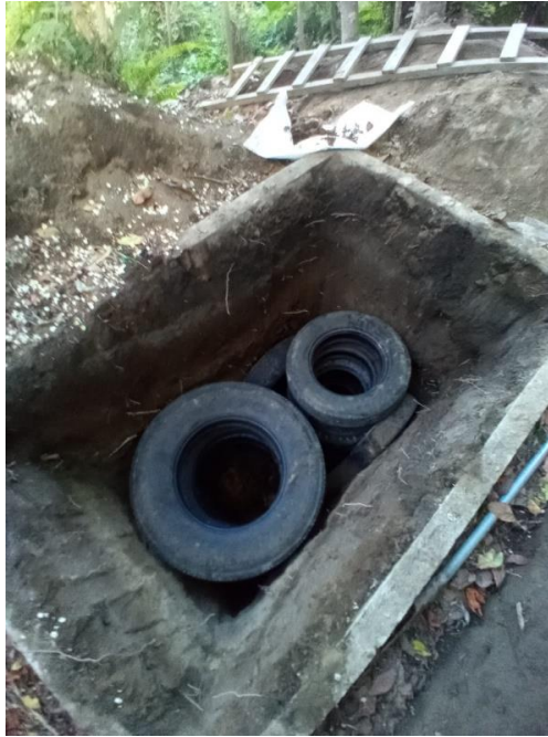
Imagen 66. Colocación de llantas en el pozo y se rellena con piedra entre llantas y pared interna del pozo.
