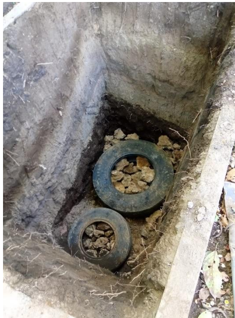
Imagen 65. Se observa llantas perforadas, las cuales se colocan una encima de la otra para drenar el agua. Fuente. Creación propia, 2022.
