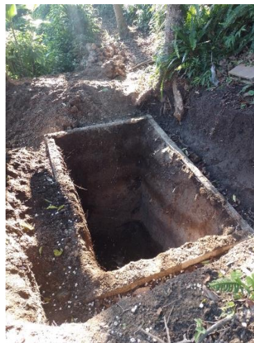
Imagen 63. Se observa broquel de bloques de concreto en la parte superior del pozo y con pendientes en las paredes internas
