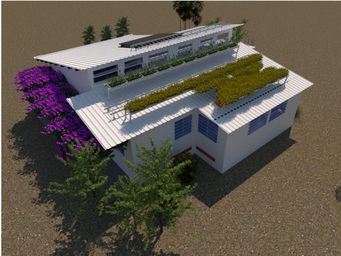
Imagen 55. Vista en planta de techo verde.
