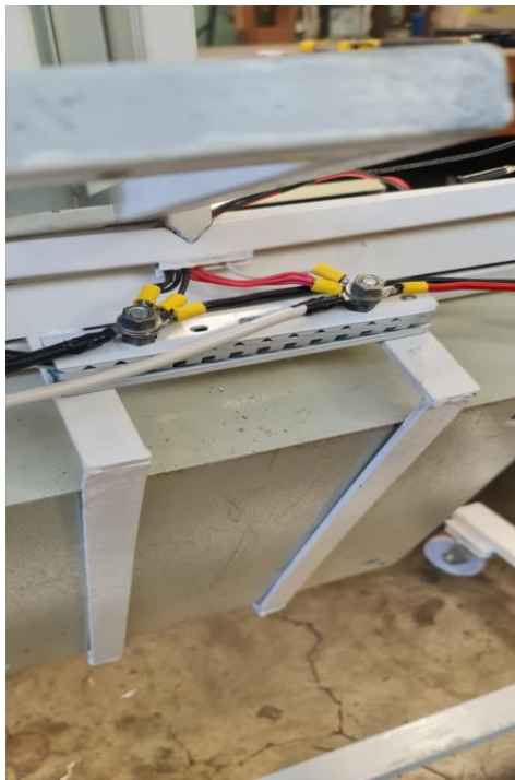
Instalación de bornes positivo y negativo.
