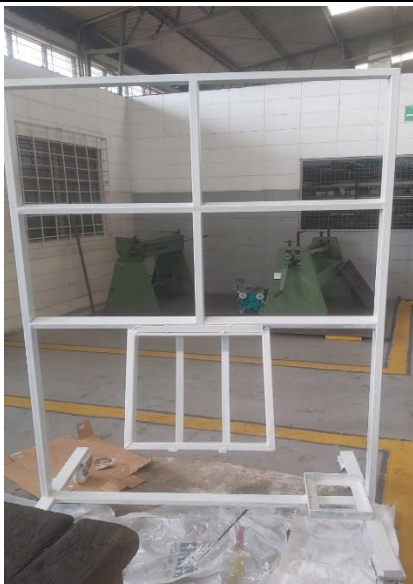
Montaje de soporte de armario de control.
