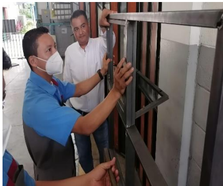
Asesoría en estructura metálica.
