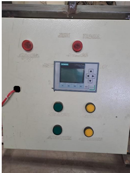
Instalación de controladores en el armario.
