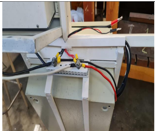
Conexión de circuito eléctrico.
