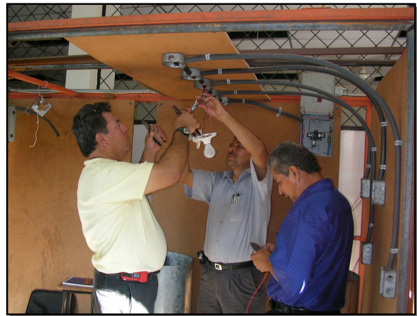
Personal de la CSJ de San Miguel realizando prácticas de instalaciones eléctricas
