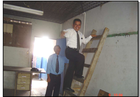
Trabajos de readecuación de la instalación eléctrica en Centro Escolar Quiñónez
