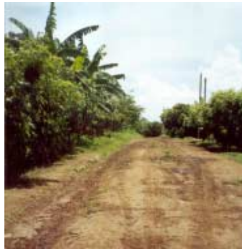
Vista panorámica de la Calle vecinal del Cantón El Barro, forjada en el suelo natural arcilloso
