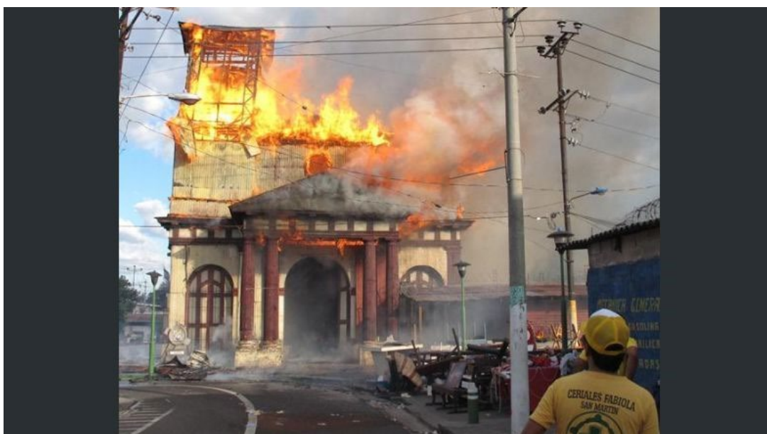
Figura 8: Incendio en la Iglesia San Esteban
