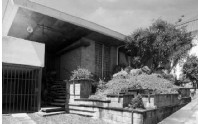
Figura 28: Casa Ortiz, 1963, San Salvador. Acceso principal
