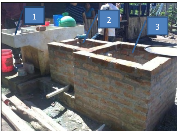
FIGURA No 39: Componentes del Biofiltro
