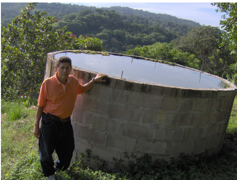
Fig 8. Don Víctor Mendoza, junto al tanque de captación de agua Lugar: cantón Santa Cruz, Municipio de San Cristóbal, Departamento de Cuscatlán. Fecha: 20 de febrero de 2006
